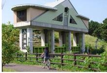
田子の浦の海面と高低差がない富士早川と下掘川が合流してできる入道川。この入道川の氾濫を防ぐために、堤防に駿河湾に排水するためトンネルを開けたのが入道樋門。現在使用されている樋門は平成12年に完成された。歴代の2つの樋門(昭和9年及び28年に完成)が公園内に展示されていて、田子の浦の歴史を感じることができる。
